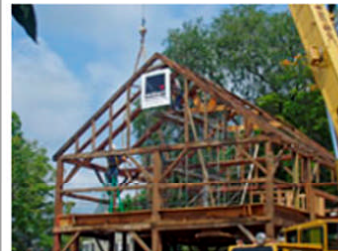
Fiske House Barn Dismantling 2004
